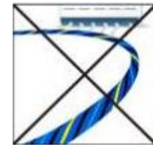
кабель под кондиционером подвержен ложным срабатываниям
